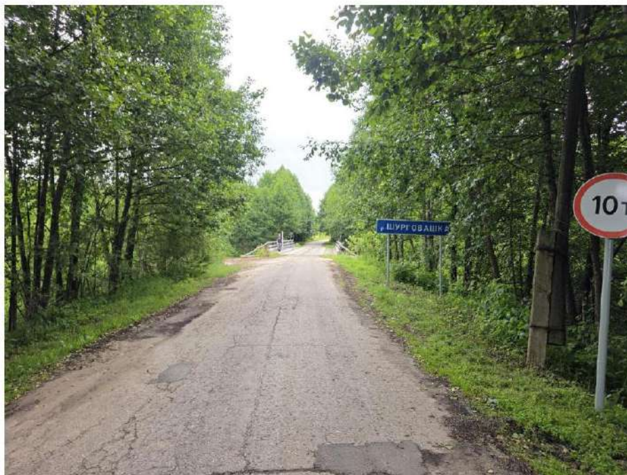
Илл. 14. Точка фотофиксации 4. Вид на исследованный земельный участок. Фото с запада на восток.
