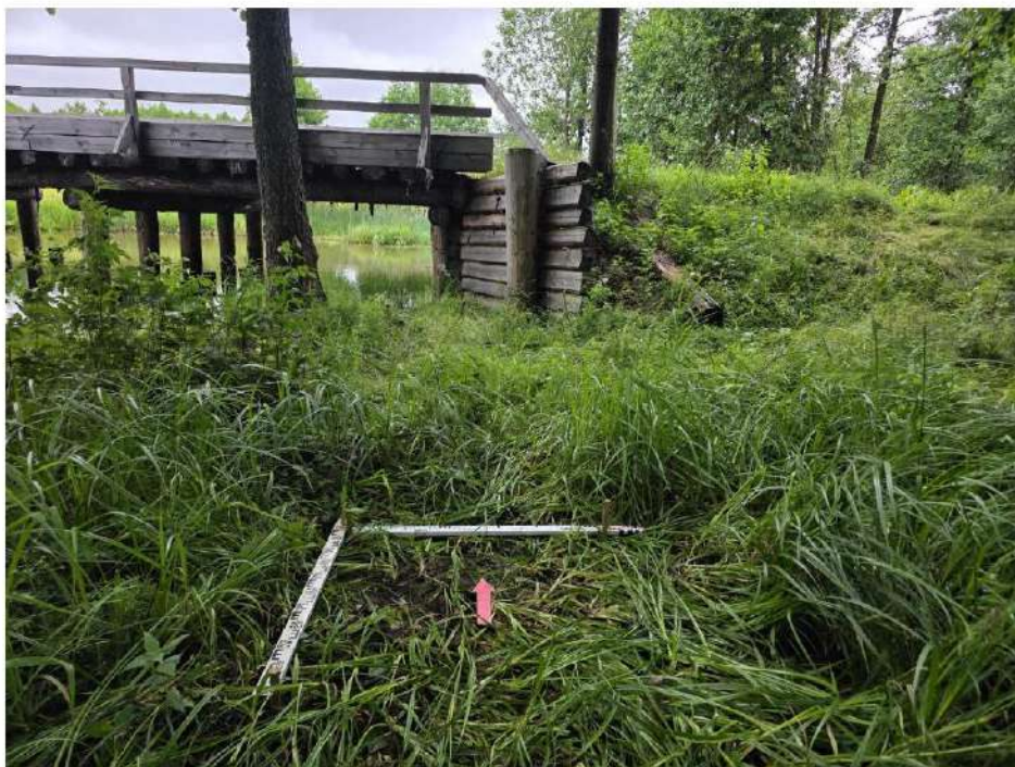
Илл. 22. Шурф 1 Общий вид перед началом работ. Фото с юга на север.
